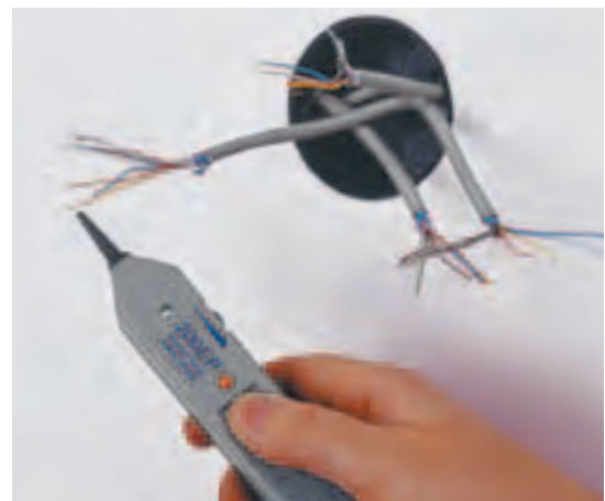
Nachdem der Sender angeschlossen ist, lassen sich die Kabel schnell ermitteln.
